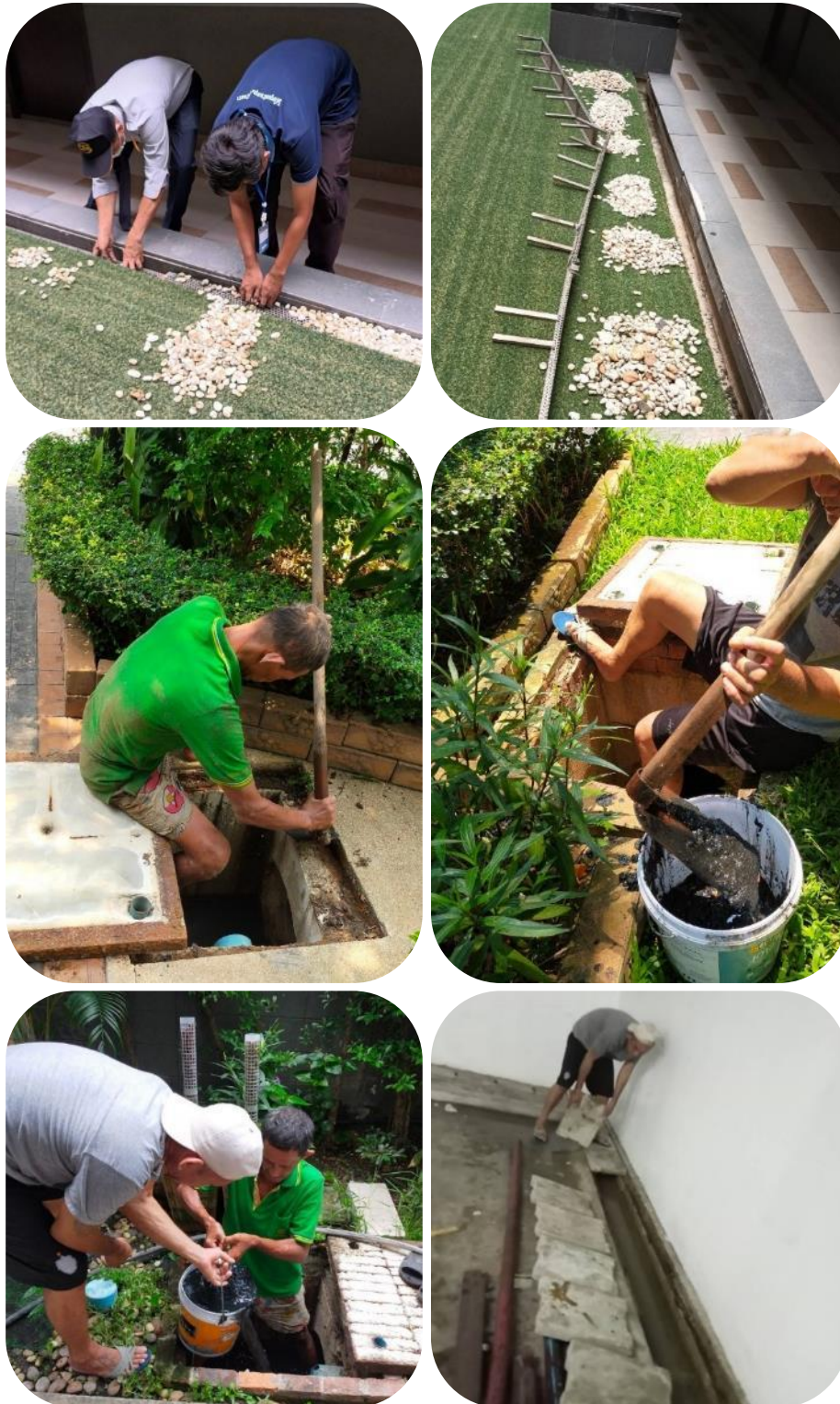
ภาพที่ 2-3.2(1) การขุดลอกท่อระบายน้ำ และตักตะกอน
