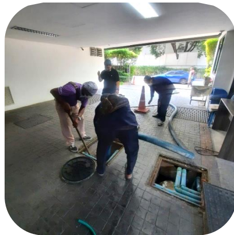
ภาพที่ 2-1.5(1) สูบน้ำบริเวณส่วนตะกอนบำบัดน้ำเสีย
