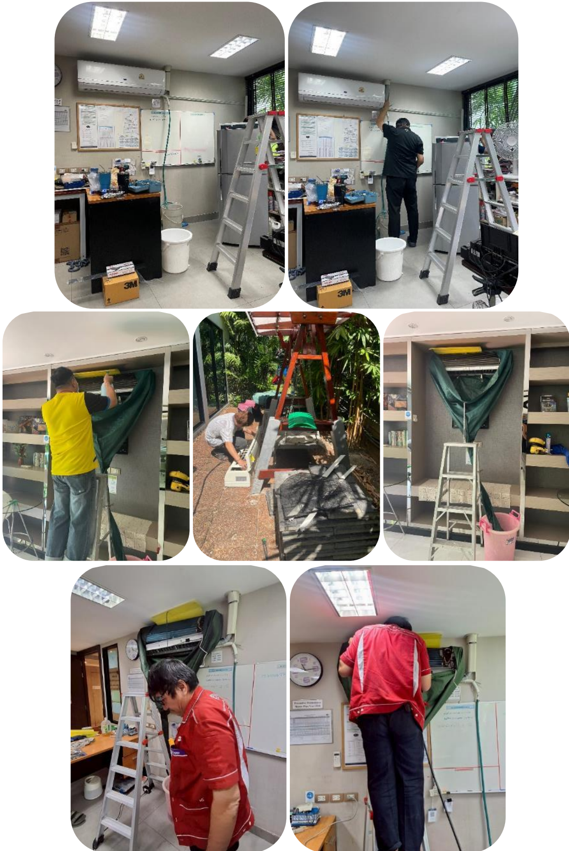
ภาพที่ 2-3.1.2(4) อนุรักษ์พลังงานโดยการล้างแผงกรองอากาศ และคอยล์ร้อนเป็นประจำ
