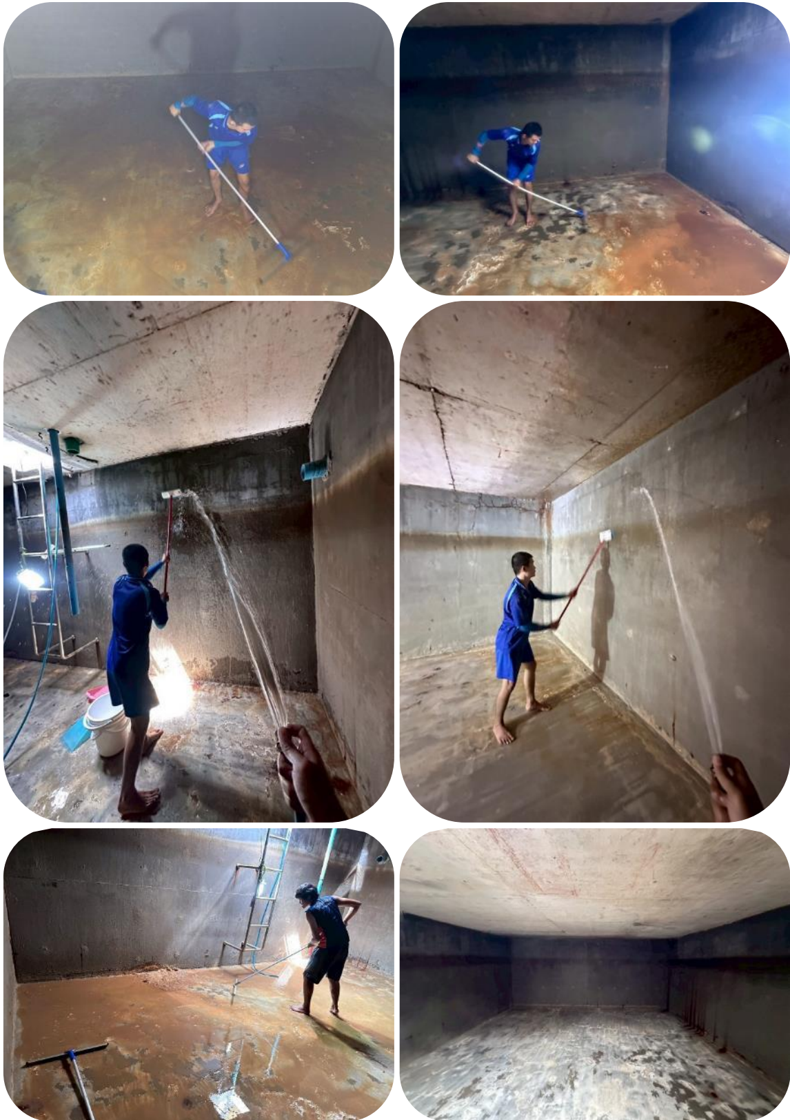
ภาพที่ 2-4.1(5) ชุดล้างทำความสะอาดบ่อพักน้ำชั้นใต้ดินและชั้นดาดฟ้าประจำปี
